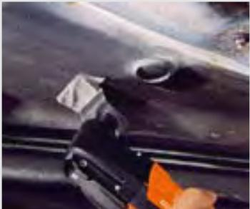
使用硬質刮鏟能夠在最短時間內除去底部保護層以及其他難以去除的塗敷層。
