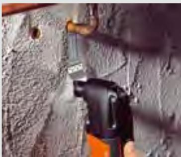
理想地用於拆卸不再需要的安裝設施：利用通用E型精確鋸片可在以後抹平牆壁時，將管材切割得與牆壁齊平。
